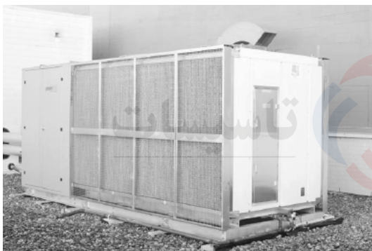
شکل ۴: چیلر نصبی در ساختمان اداری خیابان مورت ۴ کانبرا
