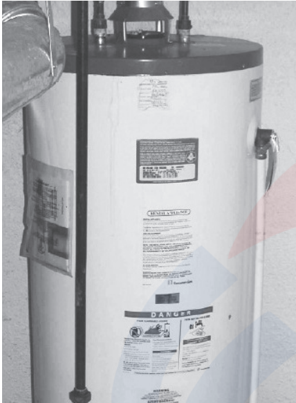
شکل ۸: آبگرمکن گازسوز مرسوم
